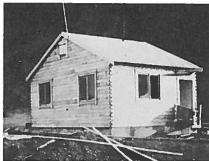
Til venstre: De første permanente boligene var brakker, av forskjellige typer og fasonger, satt opp av flak fra tyskerbrakkene. Mange bodde i slike brakker helt fram til 1950-årene. Bildet er fra Olderfjord, 1946, og viser Arne Pettersen med sin datter Laila.
