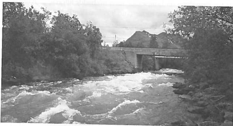
Pekkajormabrua over Kittdalselva innerst i Storffjorden Foto: Åge Mellem
