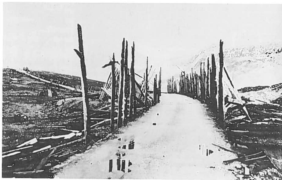
Tyskernes forsøk på å bygge vintervei over Kvæangsfjellet endte slik. Brannhøsten 1944 gikk den 4 km lange tretunnelen opp i flammer. Slik så det ut i mai 1945.
